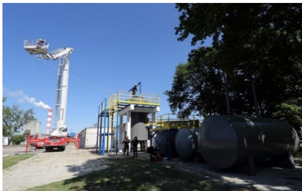
Rys. 16. Trenażer do ewakuacji z przestrzeni zamkniętej - zbiornika
