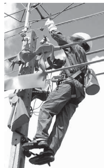
Rys. 4-5. Naprawa i konserwacja na słupach WN – ręce powyżej stawów ramiennych
