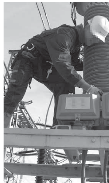
Rys. 4-8. Obsługa, konserwacja i naprawa urządzeń stacji – praca w pozycji pochylonej
