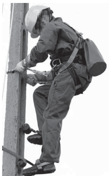
Rys. 4-3. Przygotowanie miejsca pracy na wysokości
