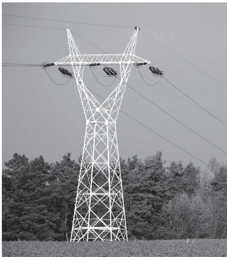
Rys. 3-1. Słup mocny linii 220 kV wraz z izolacją i przewodami
