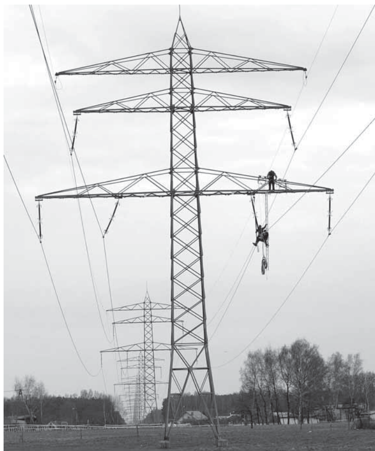
Rys. 3-7. Wymiana izolacji na linii 220 kV
