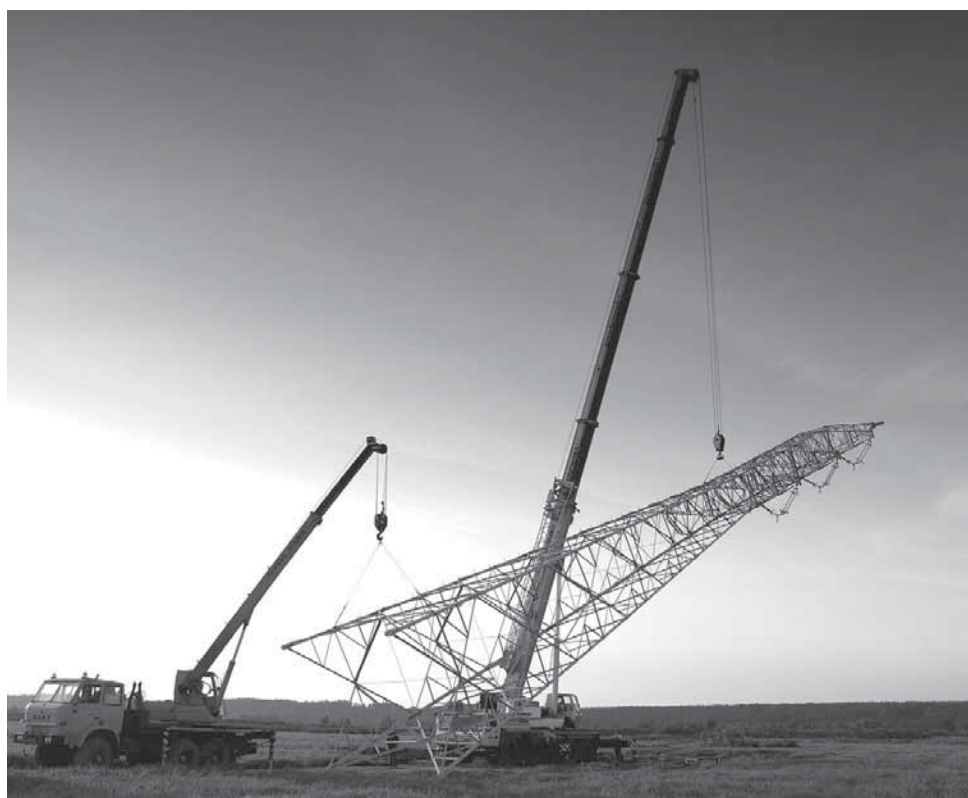
Rys. 3-14. Stawianie słupa 110 kV z wykorzystaniem dwóch dźwigów
