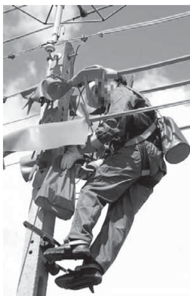
Rys. 4-4. Naprawa i konserwacja na słupach WN – ręce poniżej stawów ramiennych
