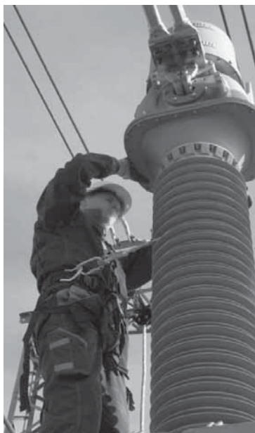
Rys. 4-7. Obsługa, konserwacja i naprawa urządzeń stacji – praca z rękami powyżej stawów ramiennych
