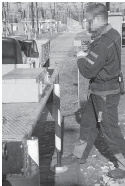
Rys. 4-6. Obsługa, konserwacja i naprawa urządzeń stacji – przygotowanie miejsca pracy
