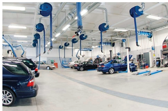
Rysunek 10. Miejscowy odciąg spalin [ http://www.mechanicssystem.com.pl ]
