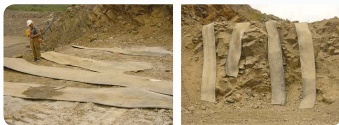
Fot. 3. Pasy gumowe zastosowane jako zabezpieczenia akustyczne przy robotach strzałowych Photo 3. Rubber belts used as acoustic safety measures for blasting works
