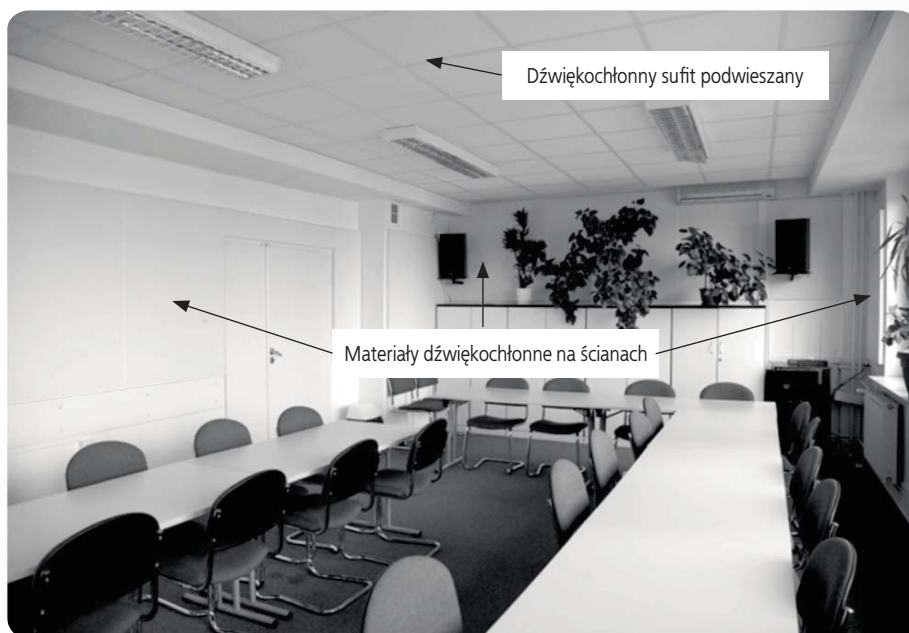
Fot. 1. Widok pomieszczenia I po wykonaniu adaptacji akustycznej Photo. 1. View of room no. 1 after acoustic adaptation
