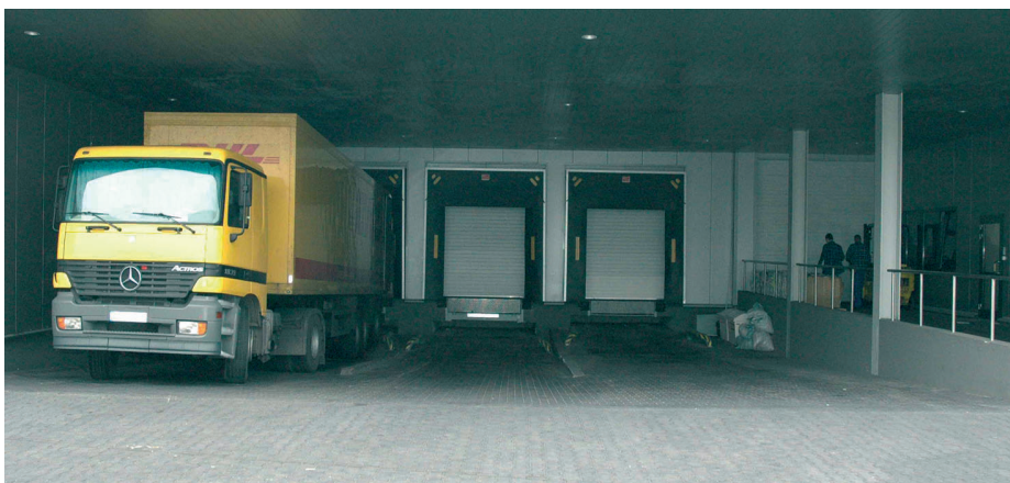
Rys. 5. Fronty przeładunkowe dla pojazdów ciężarowych
