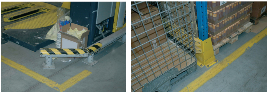
Rys. 16. Odbojnice regałów i słupów regałowych
