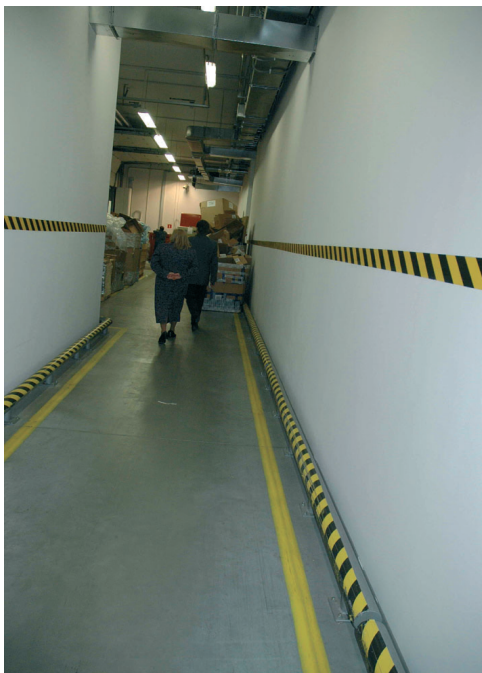
Rys. 23. Oznakowanie drogi komunikacyjnej
