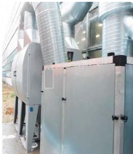
Fot. 4. Przykładowe instalacje odpylające i urządzenia filtracyjne stosowane w procesach spawania Photo. 4. Examples of dust removal installations and filtration devices in a process enclosure
