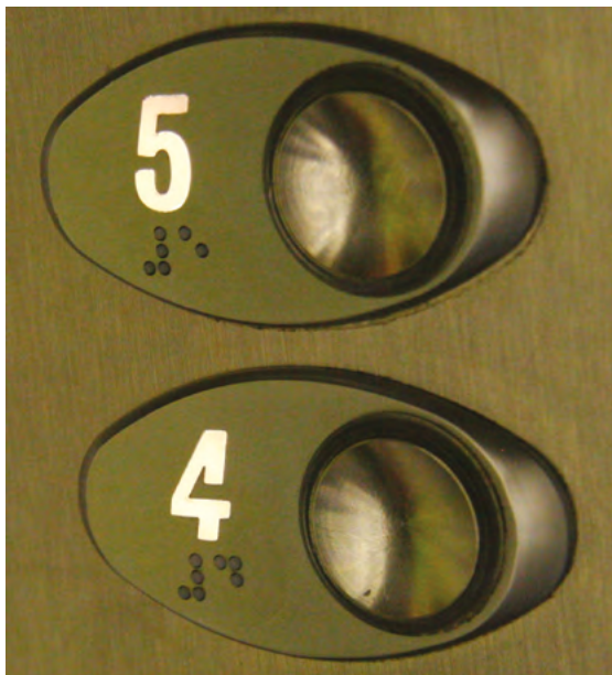
Rys. 3-23. Przykład przycisków na tablicy przyzywowej w kabine dźwigu osobowego dodatkowo oznakowanych za pomocą alfabetu Braille'a (źródło: CIOP-PIB)
