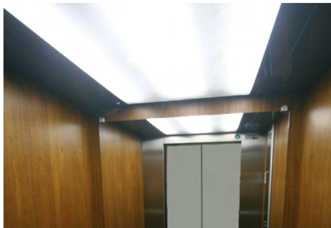
Rys. 3-15. Przykład widoku sufitu kabiny dźwigu oświetlonego za pomocą oświetlenia pośredniego (źródło: CIOP-PIB)
