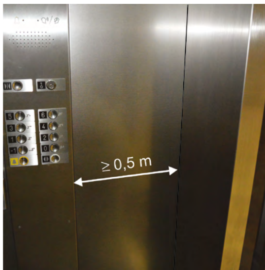
Rys. 2-17. Poprawnie wykonana i zainstalowana tablica przyzywowa z podświetlanymi przyciskami i wbudowanym modulem głośnomówiącym (źródło: CIOP-PIB)
