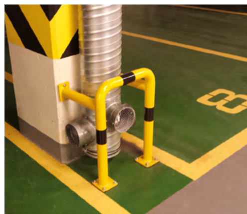
Rys. 2-22. Przykład nawierzchni posadzki w garażu wykonanej z materiału niepowodującego niebezpieczeństwa poślizgu (żywicy epoksydowej z zewnętrzną warstwą posypki), (źródło: CIOP-PIB)
