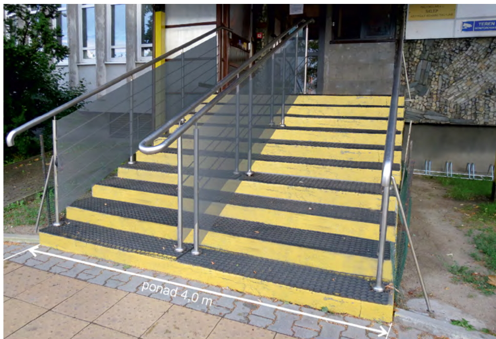
Rys. 2-9. Przykład prawidłowego zastosowania balustrady pośredniej na schodach zewnętrznych (źródło: CIOP-PIB)
