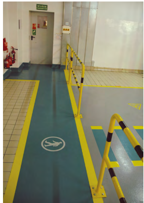
Rys. 2-51. Przykład prawidłowo wykonanej bariery ochronnej zabezpieczającej przed wtargnięciem w strefę obsługiwaną przez wózki jezdne (źródło: CIOP-PIB)
