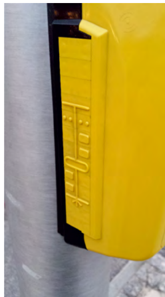
Rys. 2-28. Oznaczenie wypukłymi piktogramami układu jezdni na włączniku sygnalizatora na przejściu dla pieszych (źródło: CIOP-PIB)
