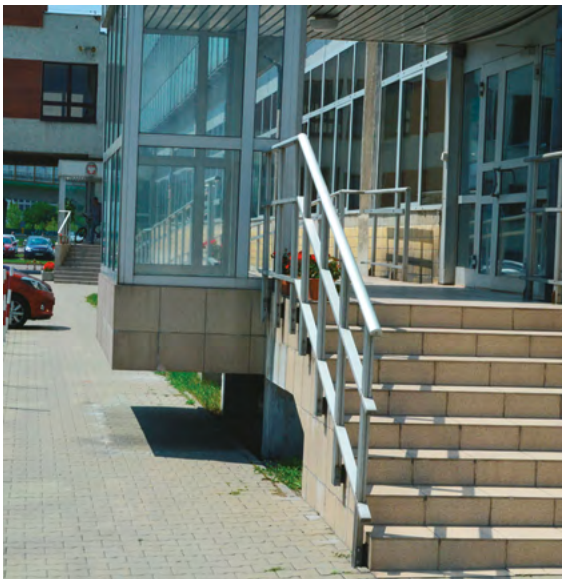
Rys. 2-34. Przykład bariery w postaci wystających elementów konstrukcji budynku nadwieszonych nad chodnikiem (źródło: CIOP-PIB)
