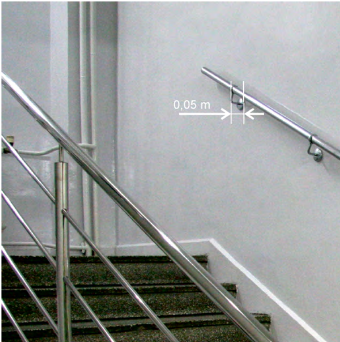
Rys. 2-15. Przykład poprawnego mocowania poręczy przyściennej (źródło: CIOP-PIB)
