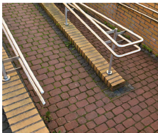
Rys. 2-21. Przykład nawierzchni pochylni zewnętrznej wykonanej z materiału niepowodującego niebezpieczeństwa poślizgu (gładko ułożonego bruku betonowego), (źródło: CIOP-PIB)
