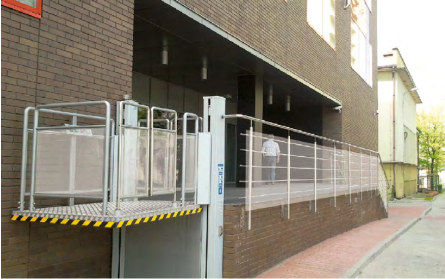
Rys. 2-52. Przykład urządzenia podnoszącego (windy) z poziomu chodnika na poziom parteru budynku (źródło: CIOP-PIB)
