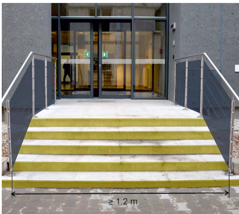
Rys. 2-8. Przykład prawidłowego rozwiązania schodów zewnętrznych (źródło: CIOP-PIB)
