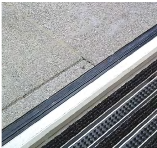
Rys. 2-20. Prawidłowo wykonany próg drzwi wejściowych (źródło: CIOP-PIB)
