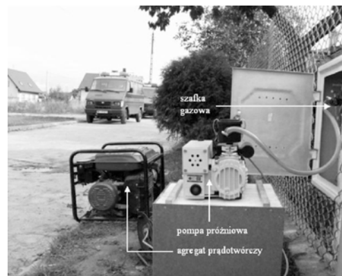
Stanowisko napełniania gazem metodą próżniową sieci (3,5 km i 100 odbiorców) w Warce k. Radomia
